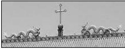
Dachfirst der Wallfahrtskirche. Foto: Archiv.
