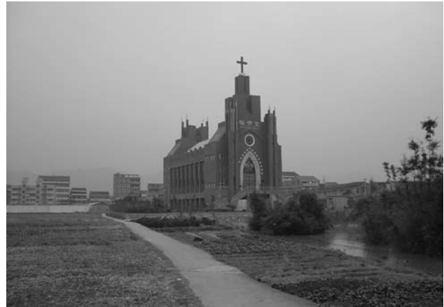
Abb. 2. Neu erbaute Kirche im städtischen Außenbezirk Wenzhous, umgeben von Reisfeldern und Fabriken in Familienbesitz. Sie kostete ca. 12 Millionen Yuan. Dies ist ein Bezirk, aus dem viele große Wenzhouer Unternehmer stammen und von dem ein bedeutender Anteil der lokalen Bevölkerung nach Übersee ausgewandert ist. An der Fassade des Kirchengebäudes stehen die beiden englischen Worte „Evangel Hall“. Foto: Autor 2007.
