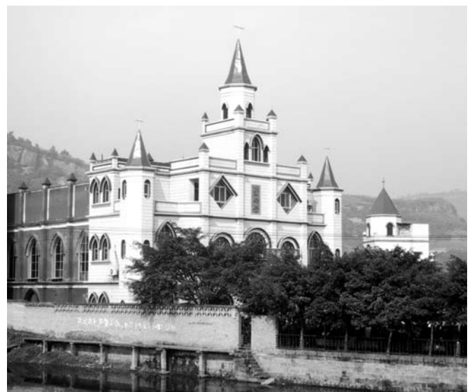
Das Pfarrzentrum von Longbao (Diözese Wanzhou) gleicht mehr einem Filmpalast als einer Kirche, meinen Kritiker.
